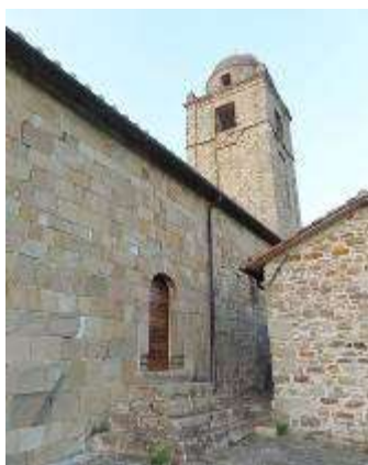
Campanile e lato sud
